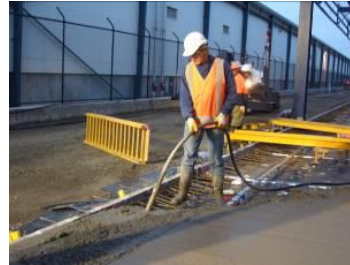
Đảm bảo bê tông được đầm lên chui vào các khe hở/rãnh
