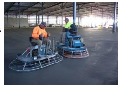
Thiết bị xoa mặt bê tông Helicopters
