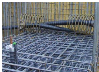
DUL trong phương ngang và phương dọc (GC - PL2) với ống chứa cáp PT-PLUS®
