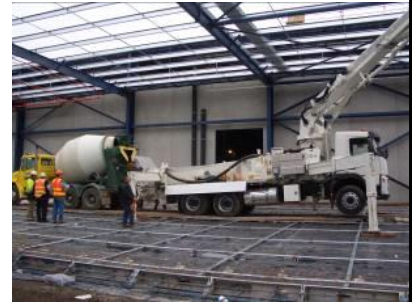
Bắc cầu gỗ hoặc thép tạm để máy bơm bê tông di chuyển
