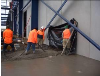
Che bảo vệ tường tránh dính bê tông
