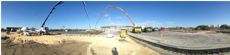
Trạm trung chuyển Container tại Úc
